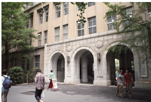
写真2 早稲田キャンパス6号館北側と南側を連結する1階
