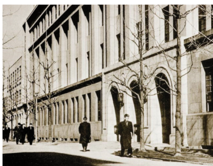
応用化学科があった現6号館 奥が小倉記念館（1959年撮影）
