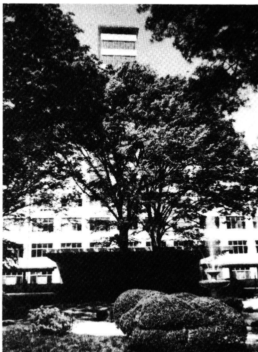
中央研究所正面玄関（東京・国分寺市）
