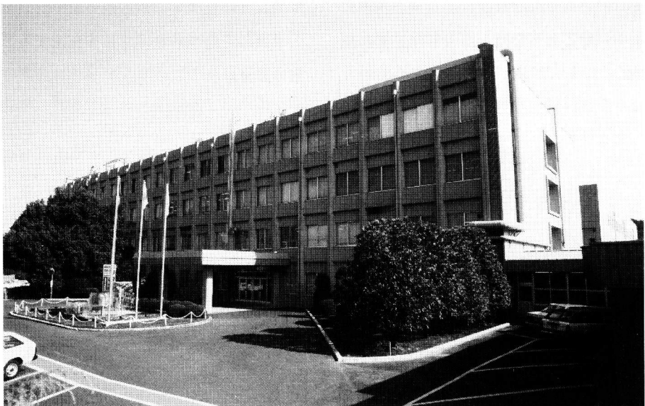
<図-1> 研究棟外観
