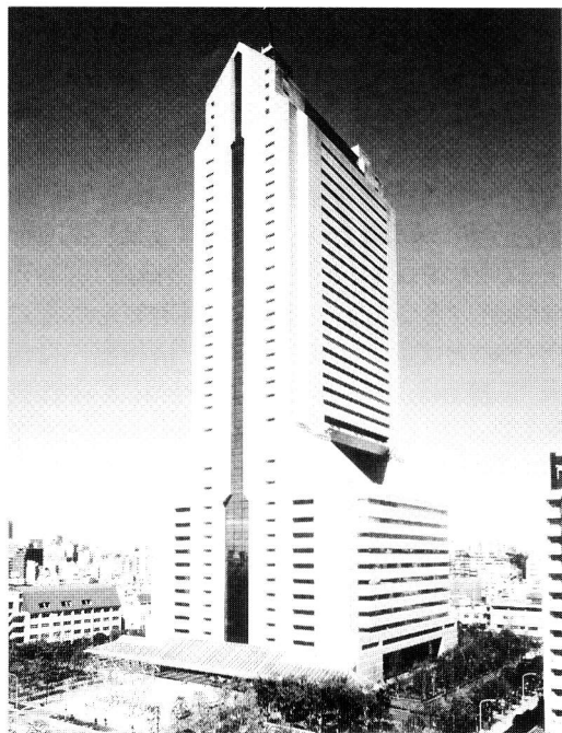
写真1. NEC本社（スーパータワー）
